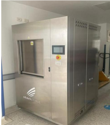
Autoclave a vapor en Central de Esterilización
